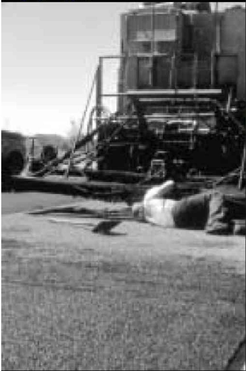
زمانی که ماشین پخش کننده متوقف شده است این مهم است زمان آن است که به طور فیزیکی آسفالت و ریزدانه های چسبیده strike off پاک کرد . همانطور که قبلا بحث کرده ایم این مخلوط مصالح باعث آثار شیاری و یا دندانه شدن در سطح راه می شود ، لازم است هر زمانی که ماشین پخش کننده متوقف می شود پاک شود .
