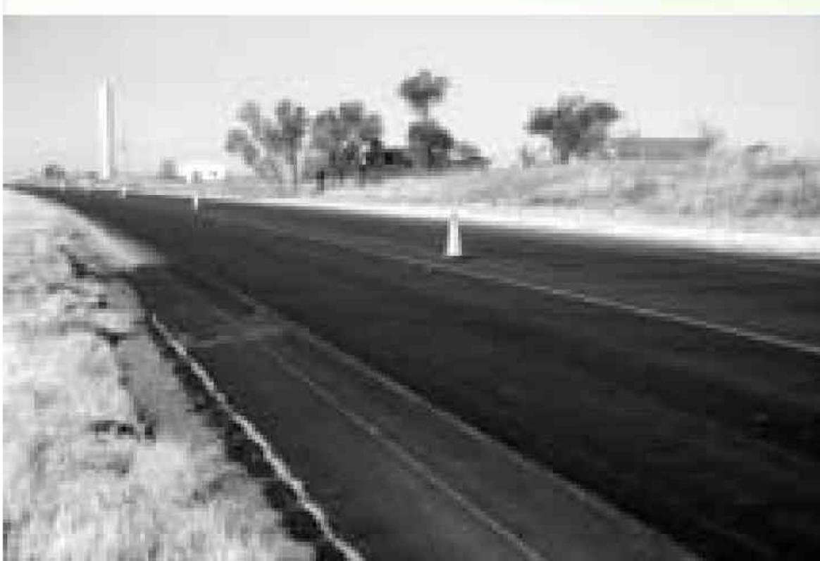
اگر پیمانکار به سختی میتواند به خط لبه مستقیم دست یابد ، چیزی که ممکن است به کمک کند این است که خط ریسمانی را در روی زمین قرار دهد و از آن به عنوان علامت هدایت کننده در اجرای خط لبه استفاده کند .
