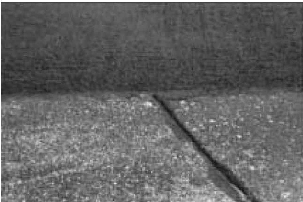
بیایید به پروژه اماده سازی ترک قبل از Micro-Surfacing بپردازیم . این به عنوان مثالی از قرار گیری مواد Micro-Surfacing در یک ترک اماده نشده است . این ترک به نظر می-رسد که پر شده است ، اما میکرو نمی تواند جلوی گسترش بعدی این ترک را بگیرد .. Micro-Surfacing موثر برای کاهش اکسیداسیون و ترک های مویی است.
