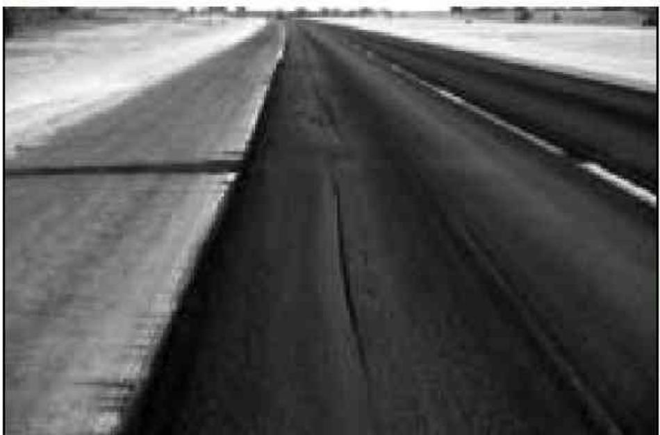
در اینجا ما برحی بیشتر از آثار چنگک کشیدن دانه های خارج از اندازه را با عامل دیگری میبینیم. آثار بزرگتر که اینجا دیده میشود به دلیل کلوخه شدن مخلوط Micro-Surfacing یا مخلوط سردی است که در در جعبه پخش گیر افتاده اند ایجاد شده است. این نوع از مشکل زمانی اتفاق میافتد که مخلوط از حالت نیمه جامد روان به حالت مخلوط سرد (به علت گیرش زود هنگام) در می آید. در این حالت فرایند پخش کردن باید متوقف شود تا زمانی که پیمانکار تعیین کند که چگونه فرایند شکست را به تأخیر بیندازد تا این مشکل از بین رود.
