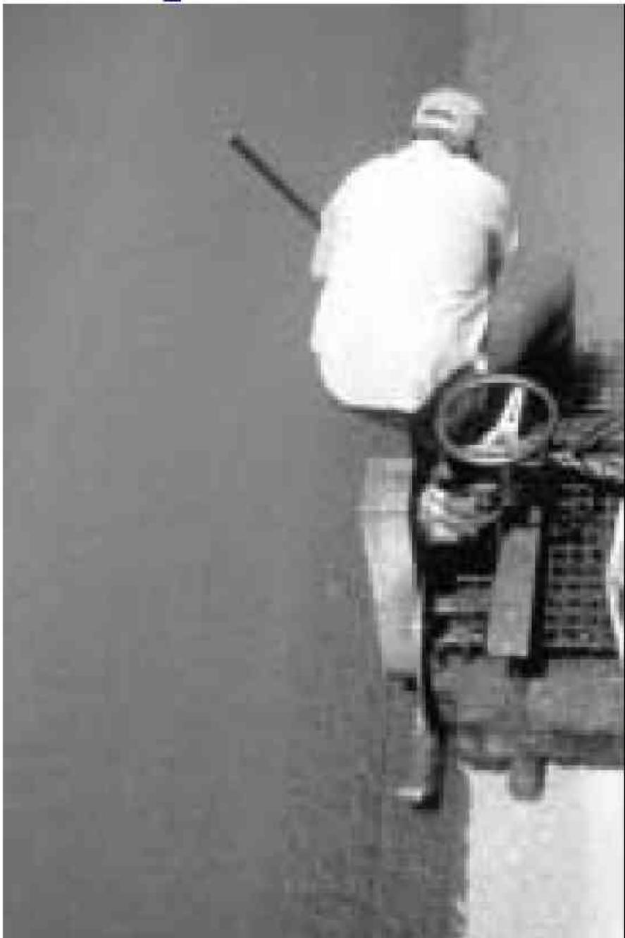
همانطور که در اسلاید قبل اشاره کردیم ، یک همپوشانی ده سانتی متری در اتصالات طولی مجاز است ، اما توجه باید به حداقل رسانی ضخامت مصالح در محل درز معطوف شود . در اینجا یک کارگر بر روی اجرای نوار دوم در درز با تی کار میکند تا ضخامت را به حداقل برساند . این روش قابل قبول برای کمک به مسطح سازی محل درز و هموارسازی هنگام رفت از یک خط به خط دیگر است.
