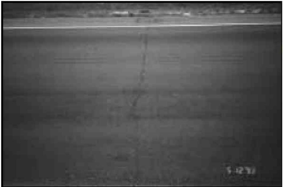
همانطور که اینجا دیده می شود یک ترک در در لایه Micro-Surfacing با عمر دو ساله دوباره ظاهر شده است . ترک های بیش از ۶ میلیمتر همیشه قبل از اینکه میکرو اجرا شود باید درزگیری شوند . بین ۱ تا ۶ ماه بین اجرا میکرو و پایان درزگیری فاصله لازم است .
