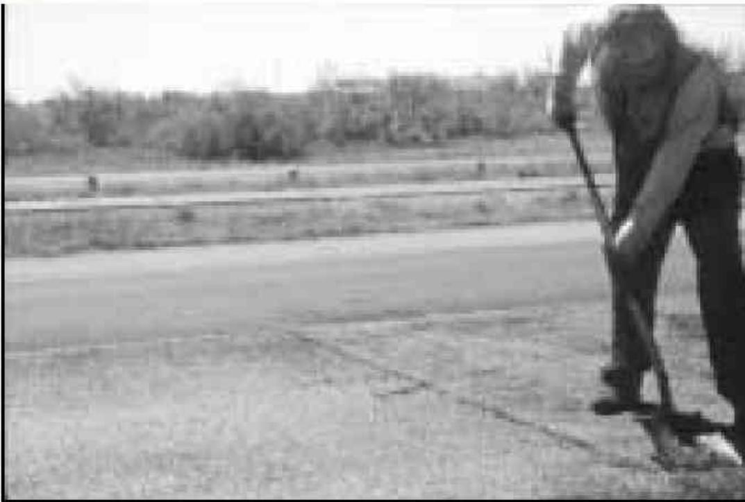
درز عرضی باید به صورت اتصالات لب به لب باشد نه درز با همپوشانی . روش توصیه شده برای اتصال لب به لب خوب این است که ابتدا خط لبه مستقیم در مخلوط موجود بریده شود (شکل). سپس جعبه پهنه کننده به صورت عمود بر راه، مجاور لبه بریده شده قرار میگیرد . جعبه پخش کننده سپس با مصالح تازه پر می شود و فرایند پهنه کردن مصالح انجام می شود . سپس یک وسیله دستی برای پیرایش درز عرضی استفاده می شود .
