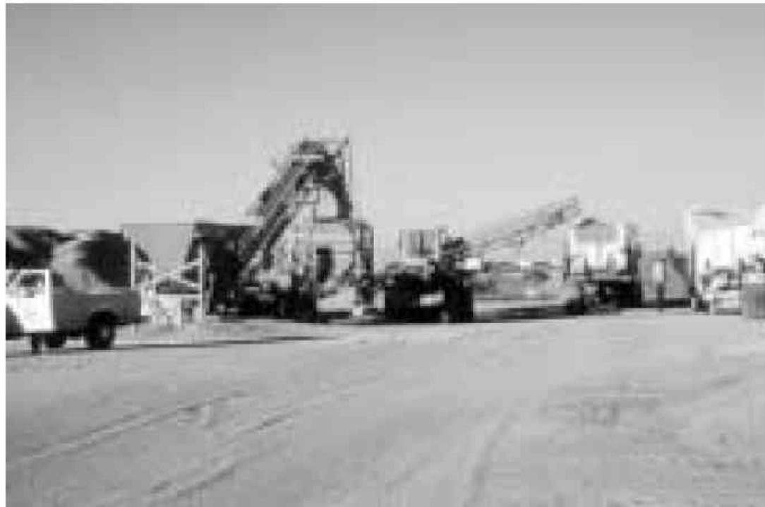
محل ذخیره (سایت) ، تجهیزات پشتیبانی ، و ماشین پخش کننده . اسلاید ناحیه ای را نشان می دهد که سنگدانه سرند شده ، وزن شده ، و در کامیون هابارگذاری میشود تا به ماشین پخش کننده تحویل داده شود . اگرچه سنگدانه از مصالح شکسته انتخاب شده اند ولی ما پیشنهاد میشود که قبل از بارگذاری به کامیون سند شونند تا دانه ای خارج از اندازه و آلودگی ها حذف شوند .. در محل ذخیره (سایت ) به طور همزمان که کامیون با سنگدانه بارگذاری میشود با آسفالت امولیسیون و اب نیز بارگذاری میشود .
