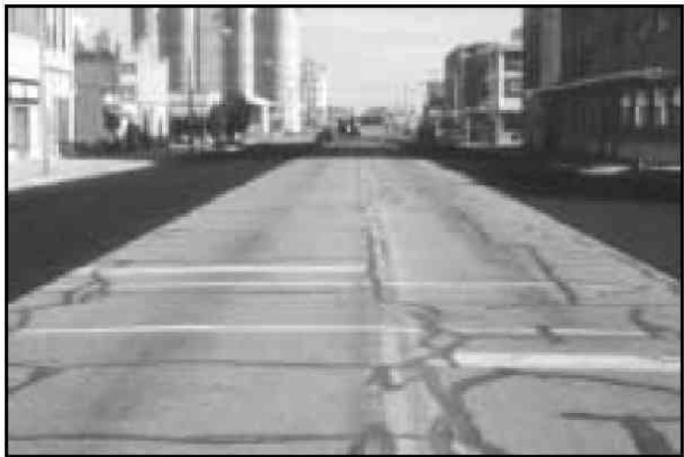
این یک نمونه از خیابانی است برای Micro-Surfacing اماده شده است ، که با عمل درزگیری ترک هم اکنون انجام شده است به خاطر داشته باشید زمانی که درزگیری ترک به اندازه کافی زود انجام شده است که ترافیک بتواند بر روی مواد درزگیری حرکت کند و آنرا به داخل ترک بکوبد و یا آنرا روی سطح راه صاف کند. راه دیگر اجرای پایین تراز درزگیری در حین اجرا درز گیر است. این به Micro-Surfacing این اجازه را می دهد که درزگیر ترک را بدون اینکه برآمدگی به جای بگذارد بپوشاند .
